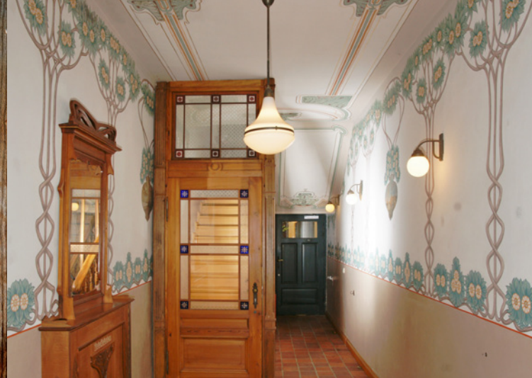
Imitationsmalerei: Eichenimitation Etagentüren, gründerzeitliches Wohn- und Geschäftshau, Keithstraße 5, Berlin
