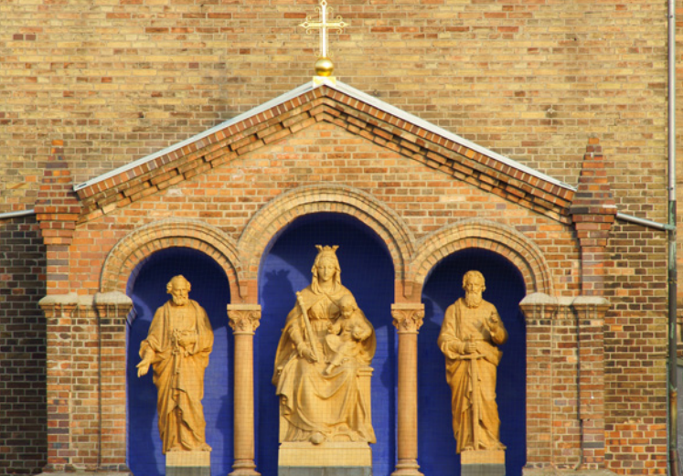
Restaurierung: Neufassung nach historischem Befund, Kirche St. Peter und Paul, Potsdam
